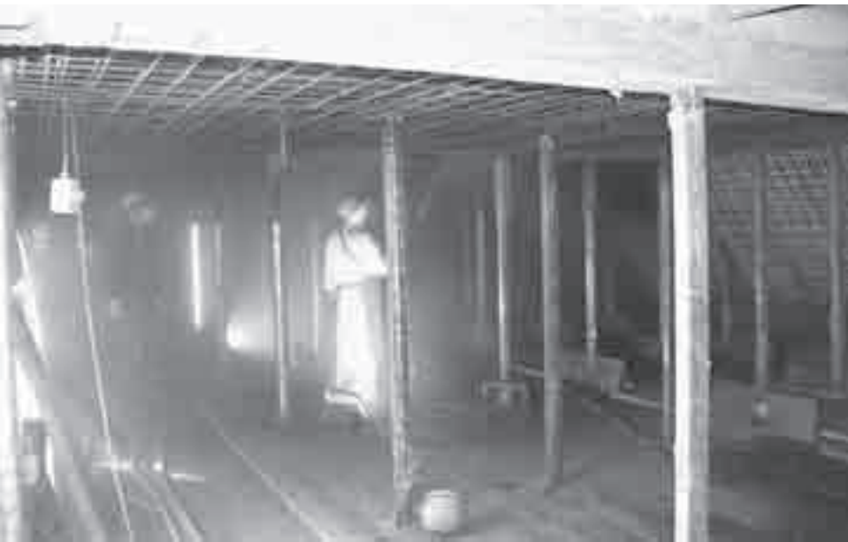
Spritzbetonarbeiten (Foto: DU Diederichs Projekt- management)
