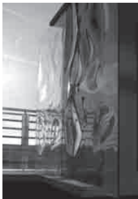
Muster der Lesesaalverglasung aus nachverformtem Glas (© HG Merz Architekten)
