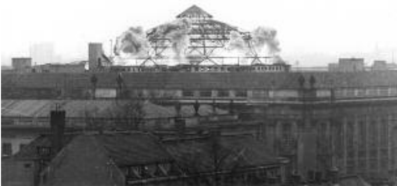
links: Sprengung der Lesesaalkuppel 1975 rechts: Bau der Büchertürme 1986
