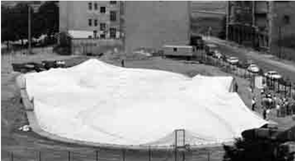
Die Traglufthalle wird aufgeblasen.
