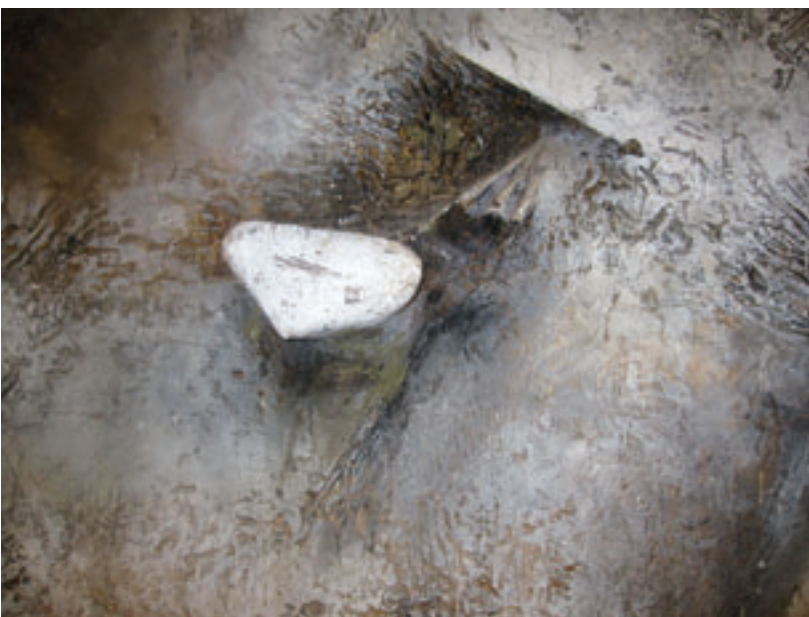
Aufragender Turm mit rückwärts einliegender Schwelle und ausgekolktem Boden
