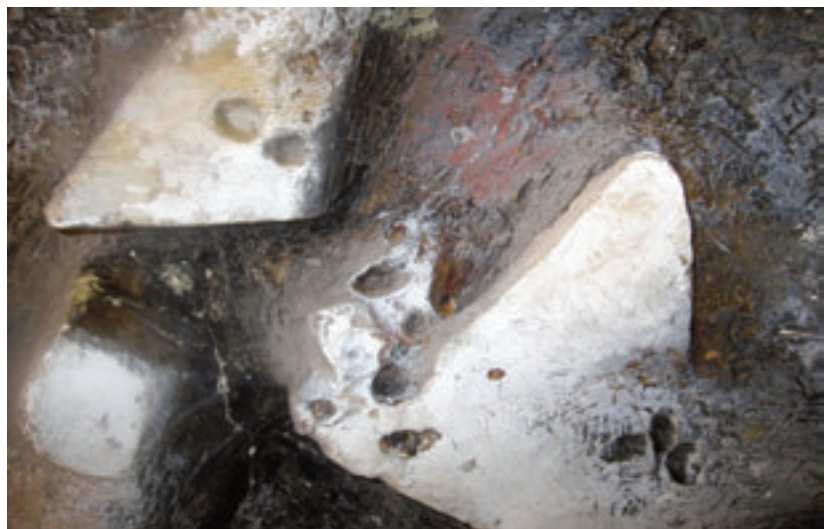
Löcher von ausgewaschenen (weicheren) Gerölleinschlüssen
