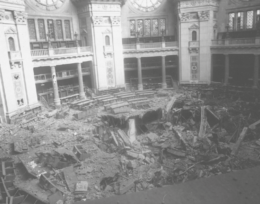
Der zerstörte Lesesaal im Februar 1944. Die Sprengbombe riss ein Loch in die Betonaußenhaut der Kuppel und durchschlug den Boden des Lesesaales.
