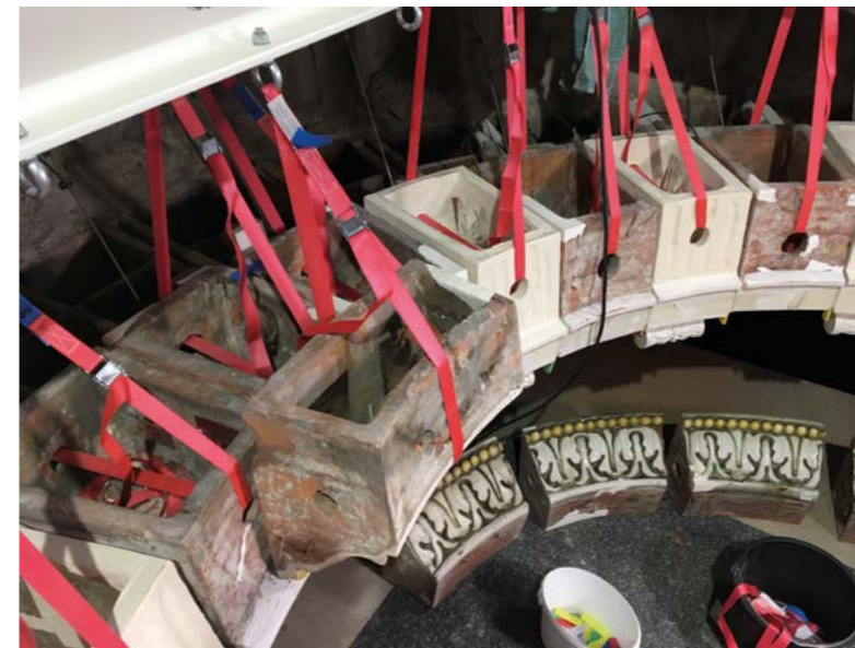
Der Majolikaring von oben: provisorische Hängung der Keramikelemente
