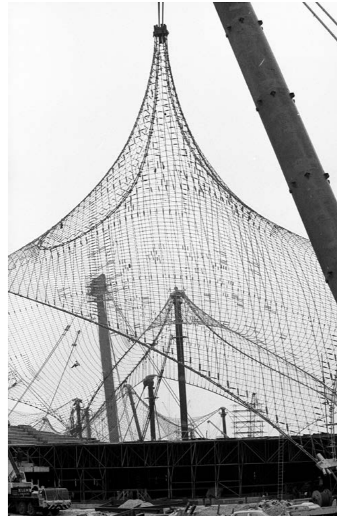
Das Dach des Olympiastadions wird empor- gehoben, August 1971 Quelle: BSB / Bildarchiv / Karsten de Riese
