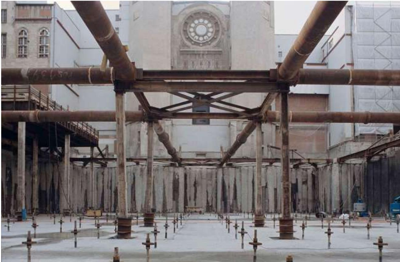
**Fertige Bausohle mit Rückverankerungen in 27 Metern Tiefe, Frühjahr 2006**
