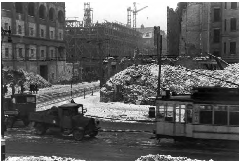
Zerstörte Häuser an der Potsdamer Straße/Pallasstraße – im Hintergrund der im Bau befindliche Hochbunker, 1944/45
