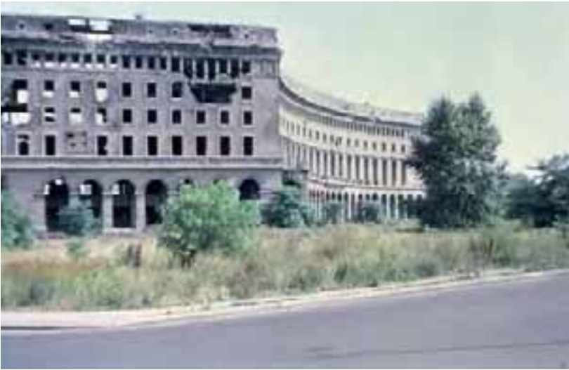
Die Ruine des Hauses des Fremdenverkehrs um 1949 (Foto: bpk Berlin)
