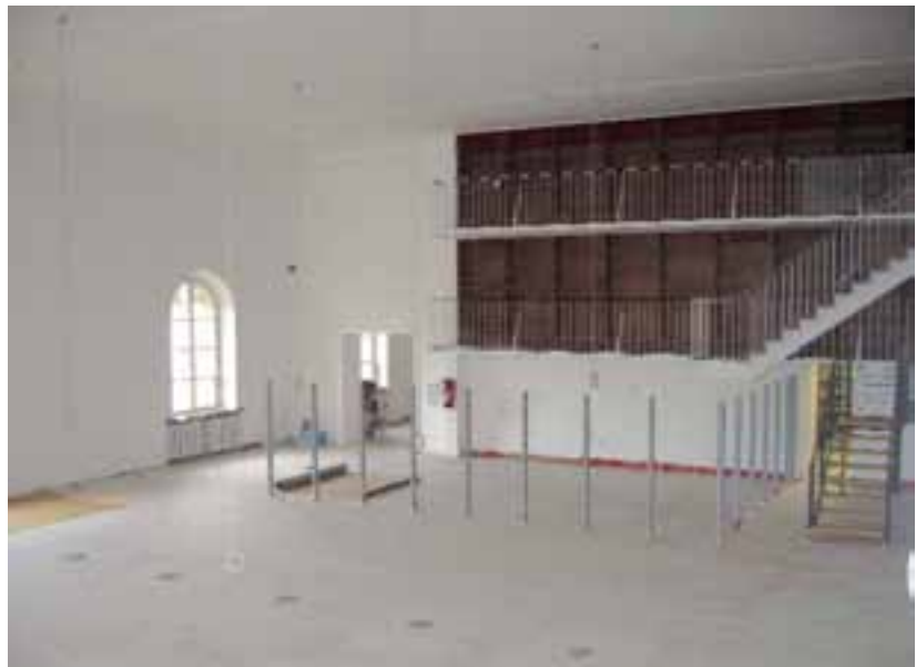
Zu Beginn des Umbaus
