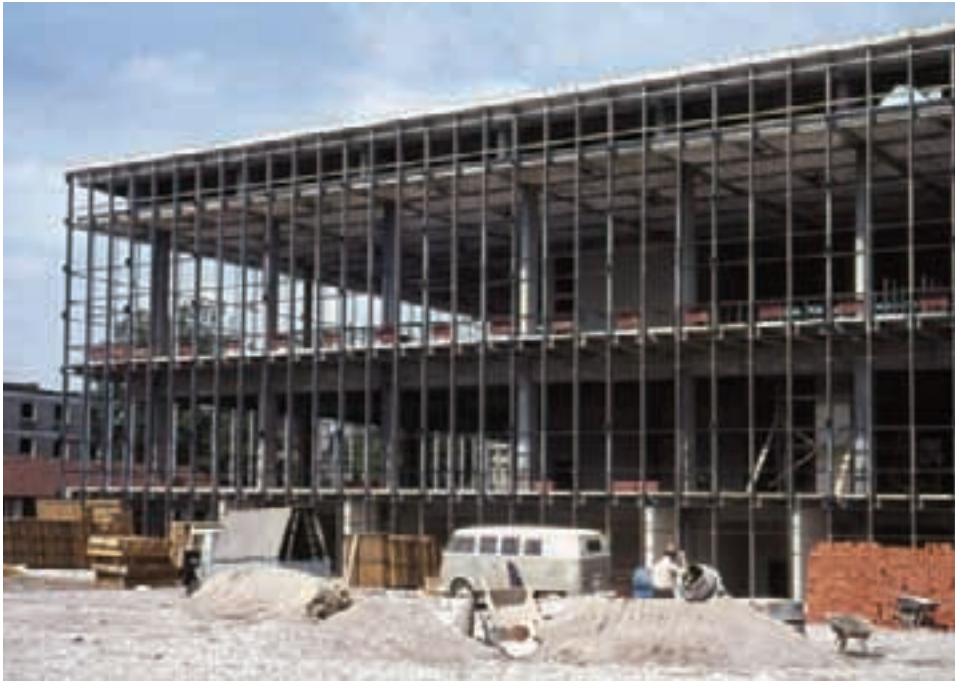
Erweiterungsbau um 1963 (Foto: Helmut Kirsten/Architektur- museum der Technischen Universität München)
