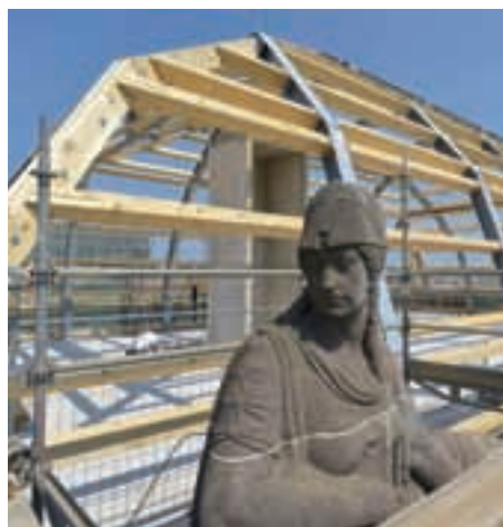
... und während des Richtfestes der Neuerrichtung
