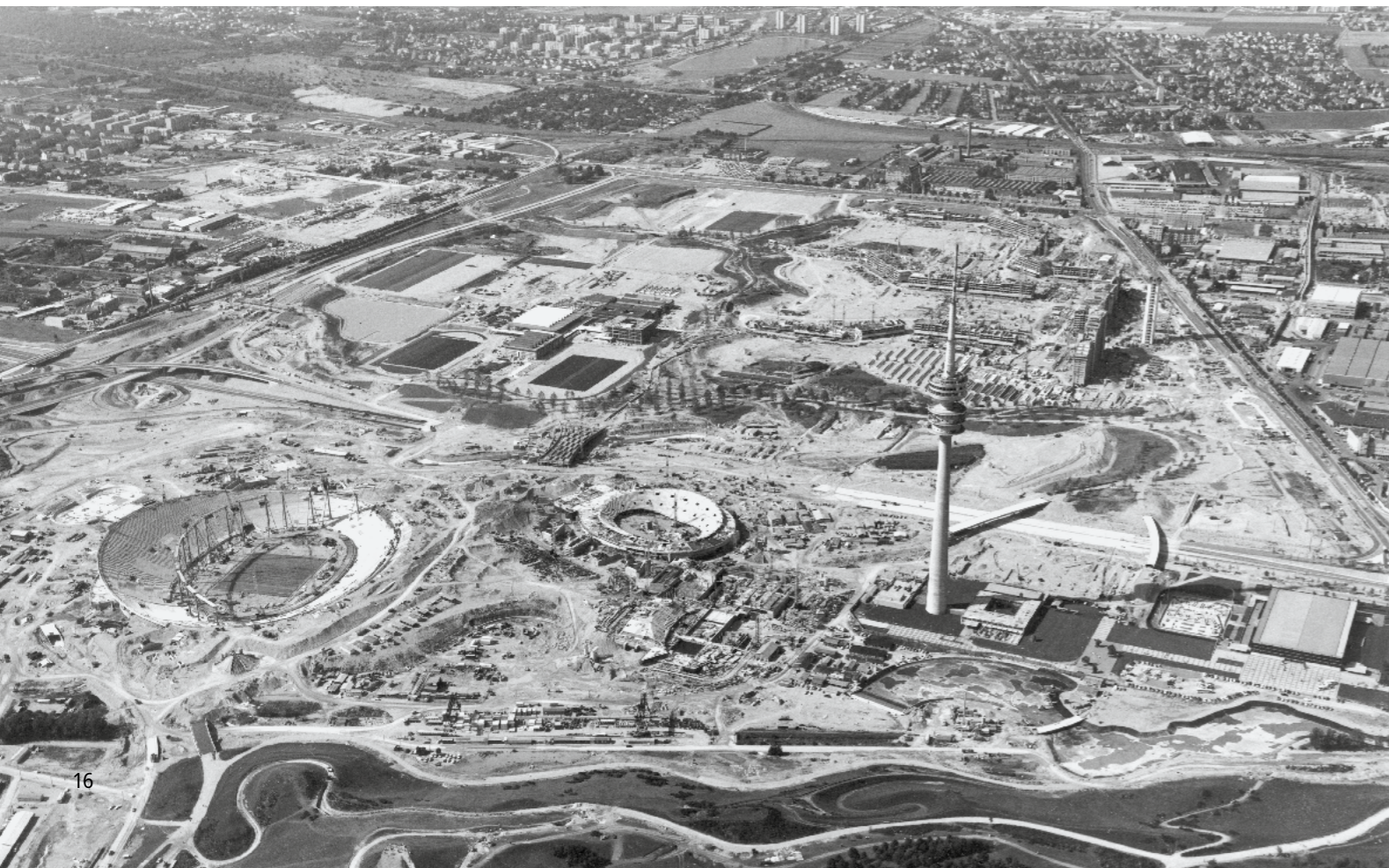
Bauarbeiten für den Münchener Olympiapark
