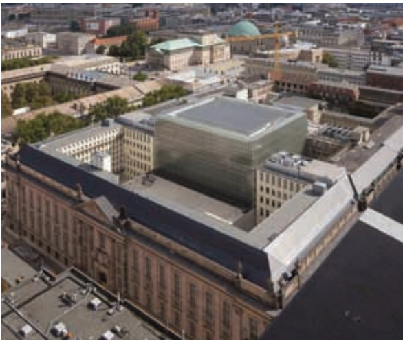
Im Zentrum des gewaltigen Altbaus steht der neue Lesesaal, ausgeführt als Glaskubus.
