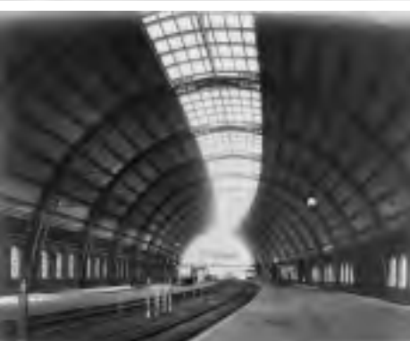
Der „Centralbahnhof“ Friedrichstraße. Ansichtenfolge mit Aufnahmen nach der Fertigstellung im Mai 1882 (Quelle: SBB-PK, Kartenabteilung)
