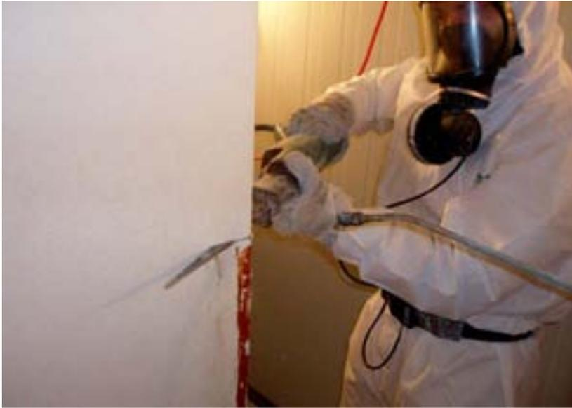
Demontage asbesthaltiger Abluftkanäle
