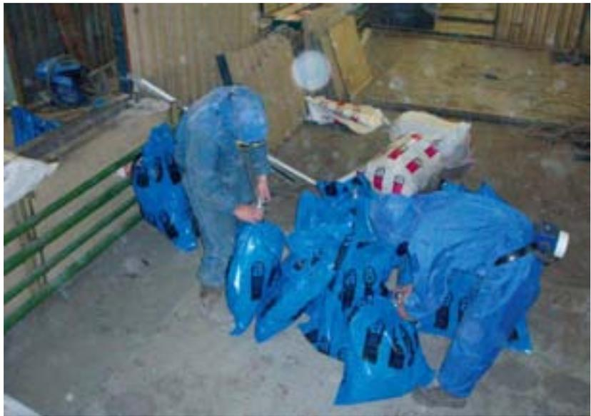
wurden am 6. Januar 2010 Kontaktproben genommen. Die Probenanalyse zeigte eine Belastung mit Asbestfasern. Der Bereich wurde vorsorglich gesperrt. Am 7. Januar 2010 wurde die Beprobung auf das 7. und 8. Büchergeschoss ausgedehnt, da das gesamte Hochmagazin als ein Hochregallager mit einem internen Luftverbund zwi-
