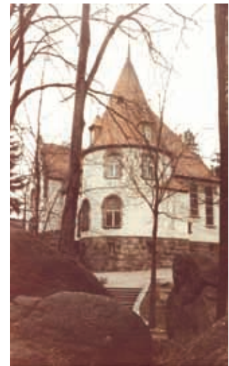
Hauptmanns Haus Wiesenstein (Agnetaendorf): Hier wurde das Briefarchiv aufgebaut
