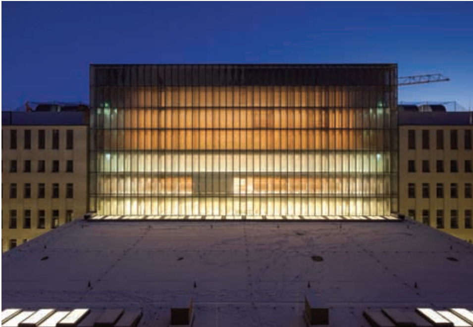
Ein neuer Ort für Forschung und Kultur mitten in Berlin: Der neue Allgemeine Lesesaal mit seiner charakteristischen Glasfassade
